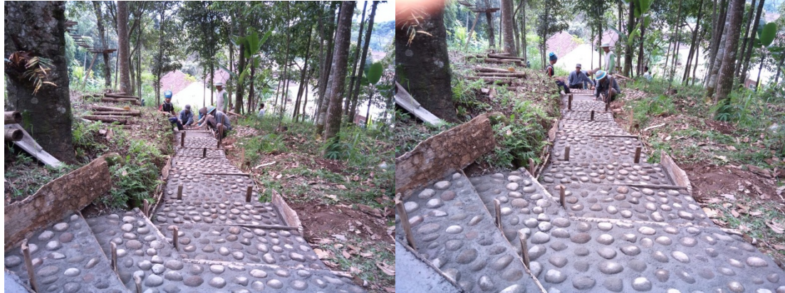
Gambar 3 Setelah Pengerjaan Jalan Setapak Menuju Lokasi Outbond
