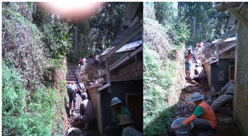
Gambar 2 Proses Rintisan dan Pengerjaan Jalan Setapak
