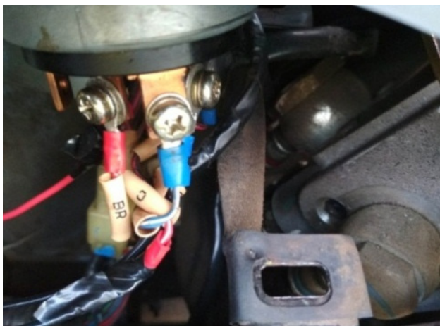
Gambar 8. Pemasangan Wiring Pada Starting Switch
