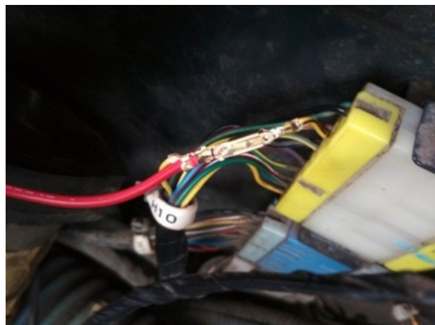
Gambar 9. Pemasangan Wiring Pada Jalur Engine Oil Level Switch
