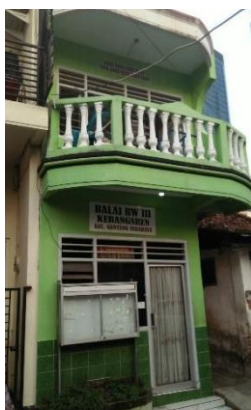
Gambar 7. Kondisi Balai RW (sumber: dokumentasi dokumentasi penulis, 2019)
