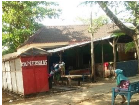
Gambar 8. Kondisi kamar mandi/WC area kuliner non formal (Sumber : dokumentasi penulis, 2019)
