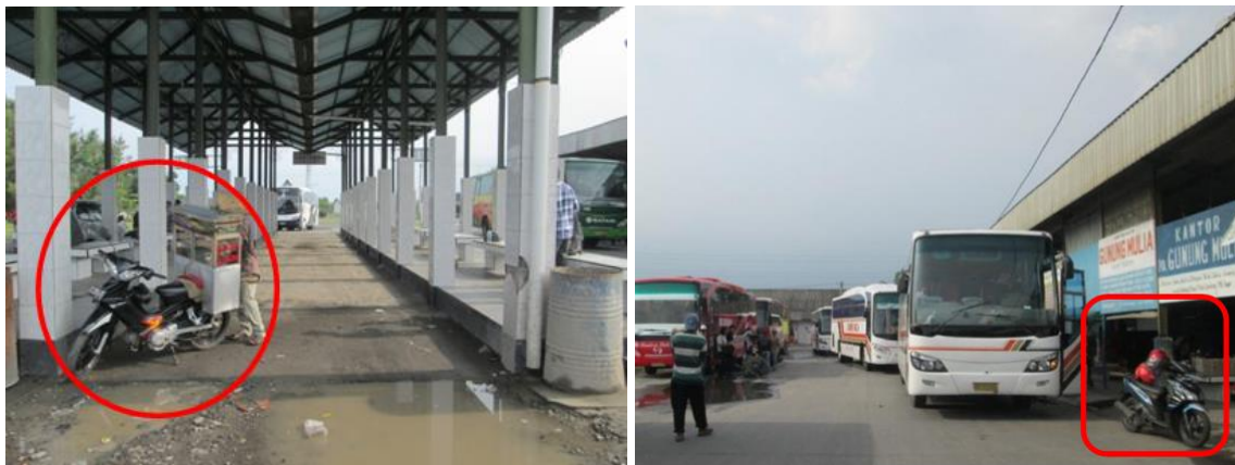
Gambar 2. Parkir tidak tertata Sumber : Dokumen penulis, 2013
