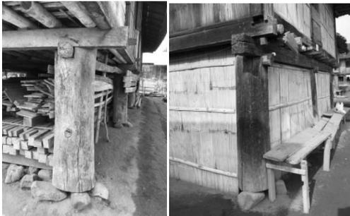
Gambar 8. Detail sambungan umpak dengan tanah
