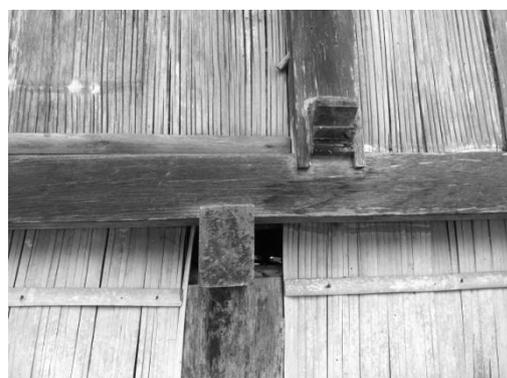
Gambar 12. Detail sambungan kolom dan balok tidak menerus
