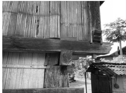
Gambar 10. Sambungan kolom dan balok tidak menerus
