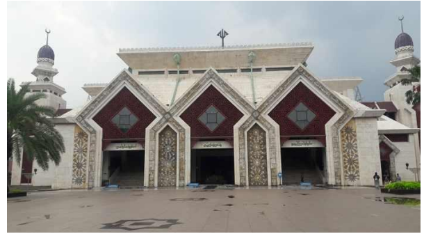
Gambar 9. Teras Masjid At Tiin (sumber: Dokumen Penulis,2019)
