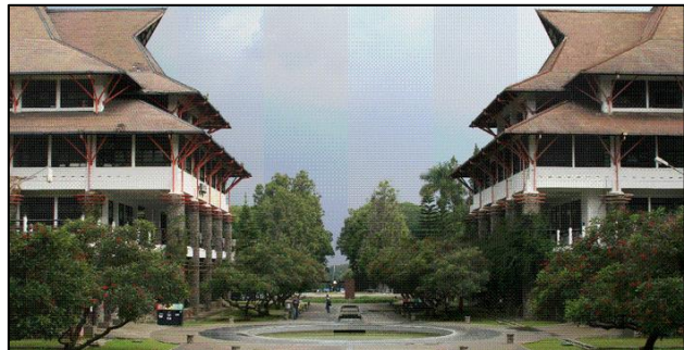
Gambar 6. Bangunan Institut Teknologi Bandung (sumber: www.ideaonline.co.id)
