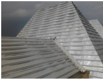
Gambar 8. Lapisan seng pada atap (sumber: Wisnu Prabowo Jati, 2013)
