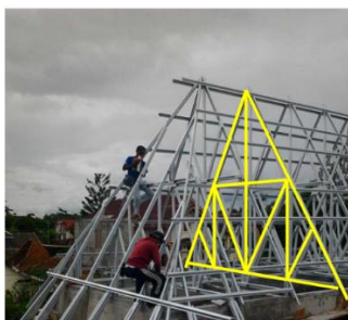
Gambar 6. Pemasangan rangka atap (sumber: Wisnu Prabowo Jati, 2013)
