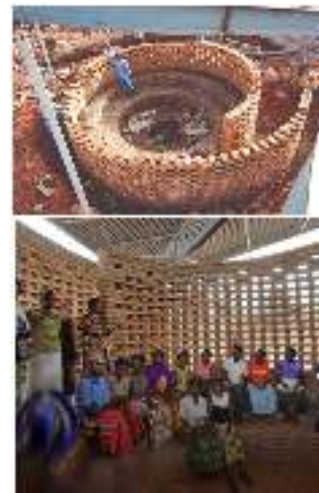
Gambar 10. Proses Pembangunan dan Hasil Ruang Kelas
