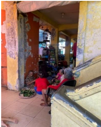
Gambar 10. Kondisi Lorong Sirkulasi Blok D (Sumber: Dokumentasi Penulis, 2022)
