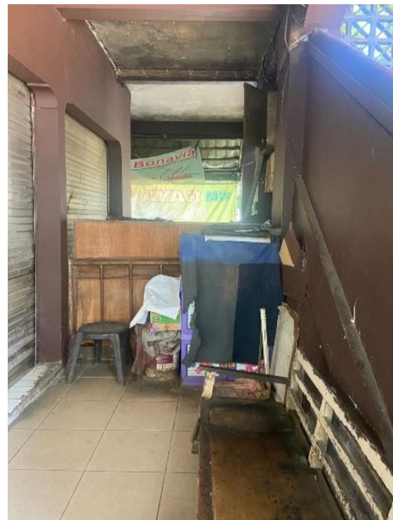
Gambar 13. Kondisi Ruang Sirkulasi Lantai Dasar (Sumber: Dokumentasi Penulis, 2022)
