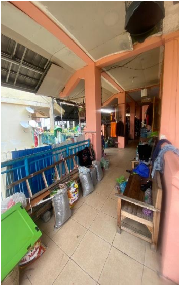
Gambar 6. Kondisi Lorong Sirkulasi Blok A (Sumber: Dokumentasi Penulis, 2022)
