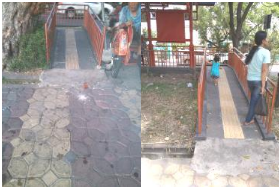
Gambar 14. Jalur pemandu yang tidak menerus sampai halte (sumber: Dokumentasi peneliti, 2018)
