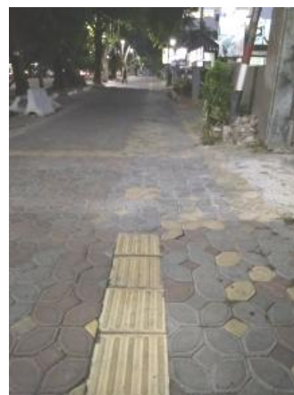
Gambar 13. Jalur pemandu terputus akibat perbaikan jalur pedestrian secara swadaya (sumber: Dokumentasi peneliti, 2018)
