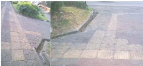
Gambar 10. Jalur pemandu hanya terdapat di bagian akses memasuki bangunan dan tikungan menuju batas city walk dengan jalan raya (sumber: Dokumentasi peneliti, 2018)
