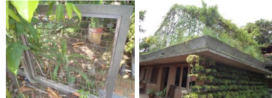
Gambar 6. Vegetasi Sebagai Atap (Kanan) dan Pagar yang Dibuat dari Paku-Paku Bekas yang Dilas (Sumber: Dokumen Penulis, 2012)
