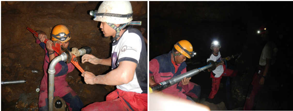
Gambar 1. Kiri: Pelepasan Pompa Submersible Kapasitas 1,5 HP. Kanan: Pemasangan Pompa Submersible Kapasitas 2 HP di Dalam Goa Suruh (Dokumentasi IbM, Juni 2014).
