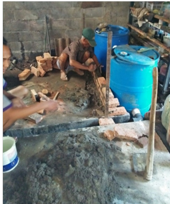
Gambar 4. Pemasangan bata untuk dinding bak tampungan dan pembuatan saluran pembuangan
