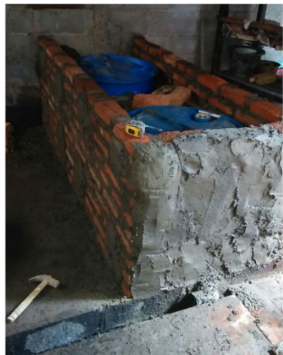
Gambar 5. Pembuatan bak penampung limbah dalam tahap finishing
