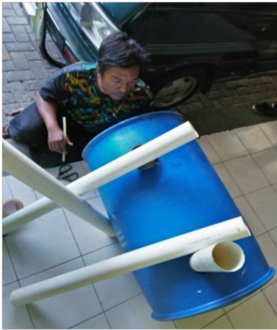
Gambar 2. Persiapan penyambungan tandon dengan pipa penghubung
