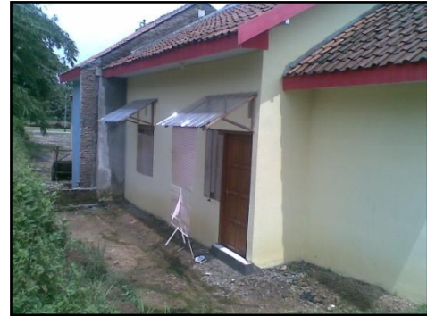
Gambar 9. Tampak belakang rumah modern Sumber : Hasil pengamatan
