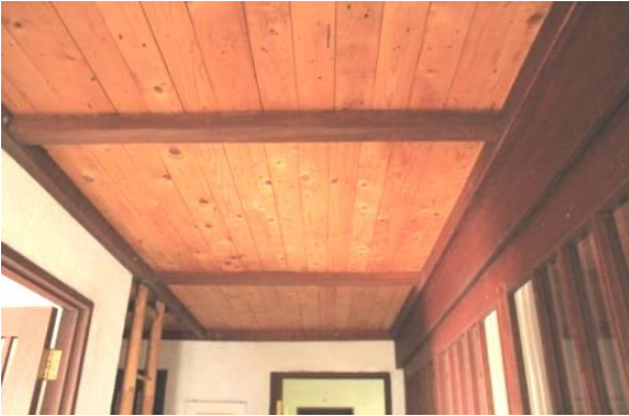
Gambar 15. Kayu peti kemas bekas yang dipasang di langit-langit selasar Rumah.
