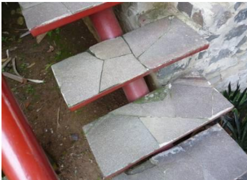
Gambar 16. Tangga pada Teras Barat Rumah dari bahan tiang listrik bekas.
