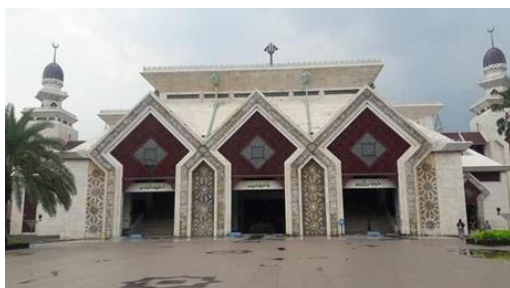
Gambar 17. Fasad depan bangunan (Sumber: Adam & Ardhiati, 2021)
