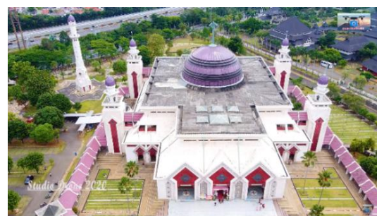
Gambar 7. Atap Joglo dan Pintu Masuk Masjid At-Tin (Sumber: Studio Drone 2020, 2020)
