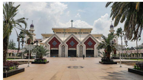
Gambar 4. Eksterior Masjid At-Tin Jakarta (Sumber: Atmajaya & Winanto, 2022)
