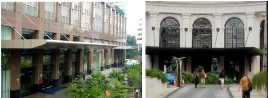
**Gambar 13.** Kanopi precast komposit ringan, kabel baja
