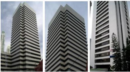
**Gambar 6.** Sirip massif pada gedung Chase Plaza dan Wisma Indocement
