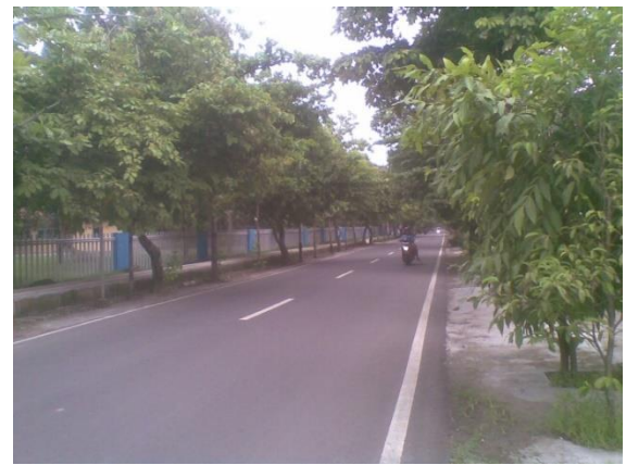
Gambar 18. Kondisi Fisik Jalan Lokal di Jalan Perintis Kemerdekaan Sumber: Survei, 2013
