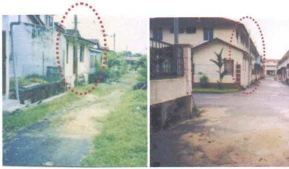
Gambar 5. Perletakan kabel telpon dan tiang listrik yang seringkali menjadi sarana bagi masuknya pencuri kedalam rumah.
