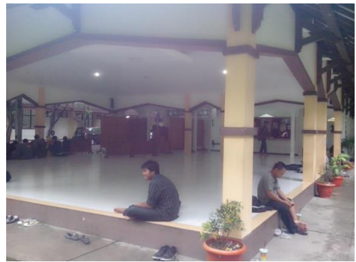
Gambar 5. Kondisi serambi masjid Ulil Albab Sumber: Survei Lapangan, 2013
