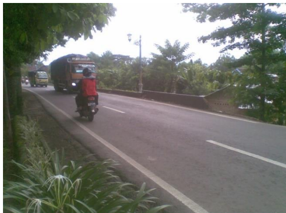
Gambar 15. Kondisi Fisik Jalan Kolektor di Jalan Kartini Sumber: Survei, 2013
