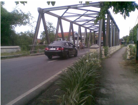
Gambar 20. Kondisi Fisik Jembatan di Jalan Kartini Sumber: Survei, 2013
