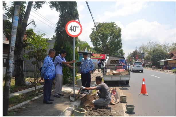
Gambar 8. Pemasangan rambu batas kecepatan maksimum kendaraan 40 km/jam.
