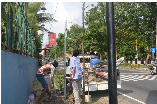
Gambar 9. Pemasangan rambu lalu lintas petunjuk penyeberangan jalan di sisi kiri jalan.
