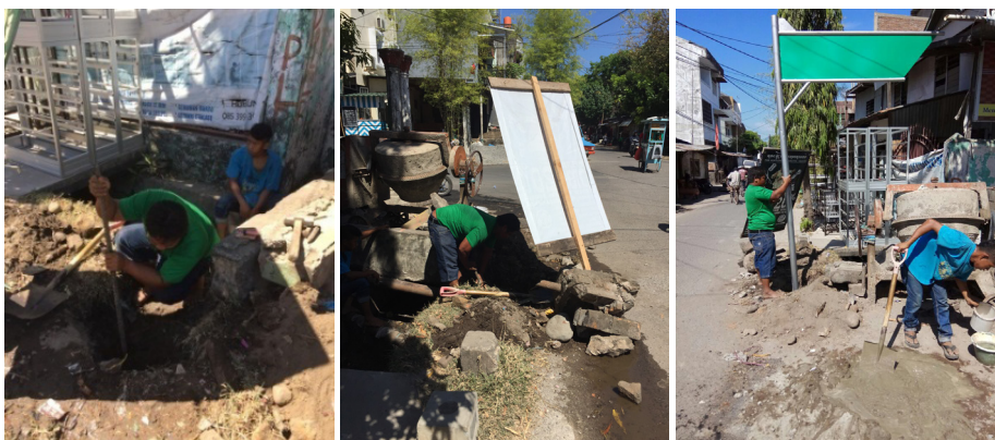
Gambar 15. Signage Telah Terpasang pada Node
