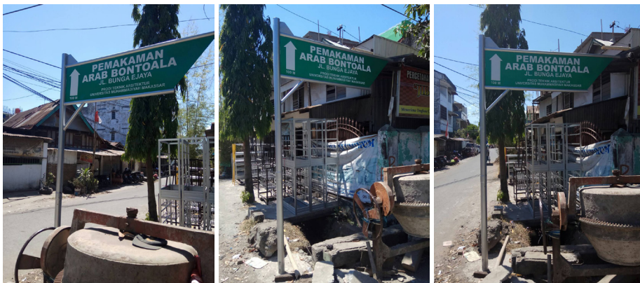
Gambar 14. Tahap Pemasangan Signage
