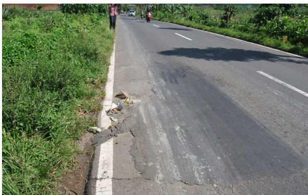
Gambar 16. Hasil survei lapangan melihat kondisi marka jalan.
